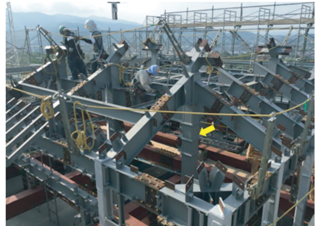
写真 1 建て方中の天守閣 6 階鉄骨造 (矢印：超狭開先 J-STAR ® 溶接技術が適用された溶接組立箱型断面柱)
